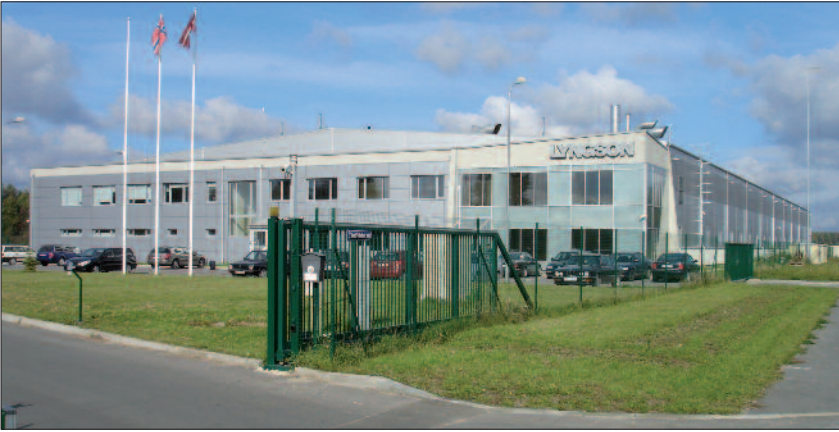
Modul och PRE radiatorerna produceras vid Epecon/Lyngsons fabrik i Riga.
