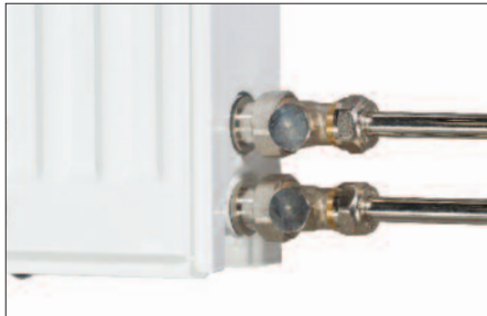
Avstängningsventil, rak. Finns i flera olika fabrikat för bl.a: 12 och 15 cu 16x2,0 och 16x2,2 Alu/Pex Byggmått Comap, A529036: 60 mm
